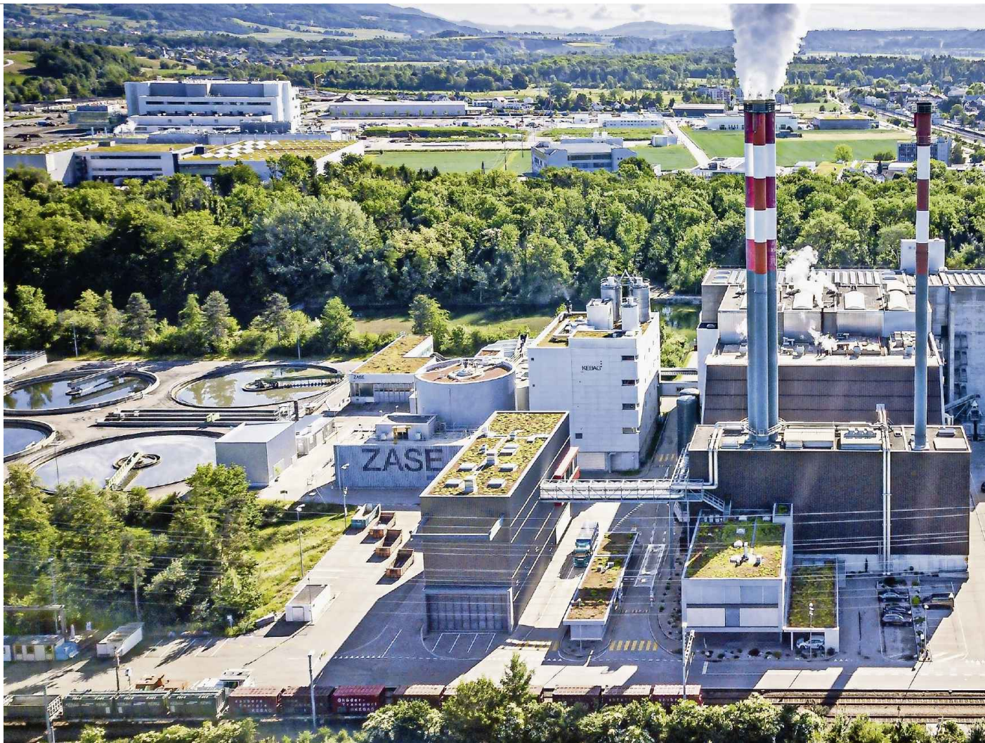
Drohnaufnahme des Kebab-Areals am Emmenspitz. 2026 beginnt der Rückbau der heutigen Anlage.
